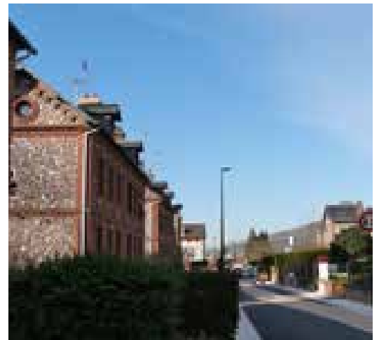
Avant les travaux, photo BE Techniroute
