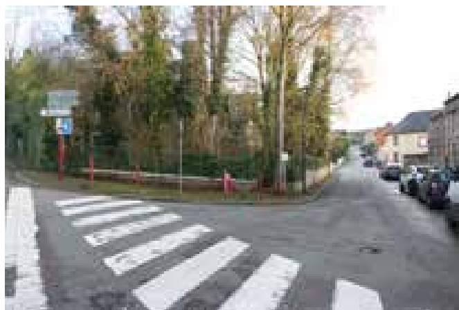
Avant les travaux...
