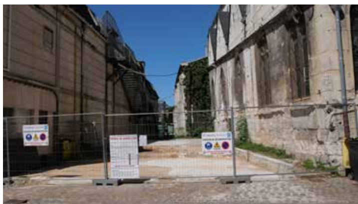
Crédit mutuel avant et après démolition
