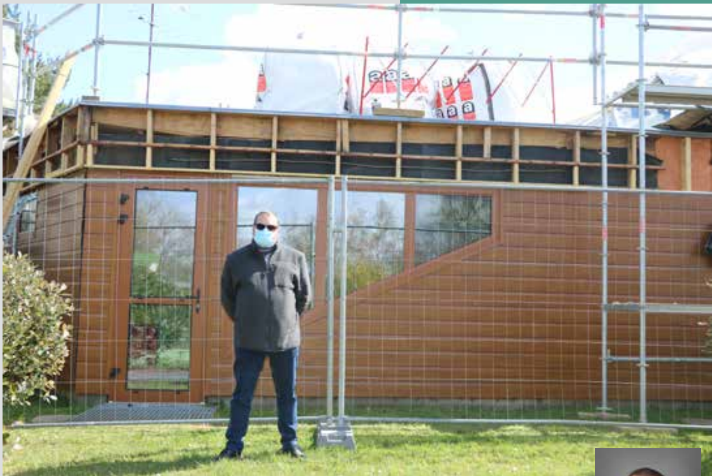
Désamiantage en cours au centre de loisirs
