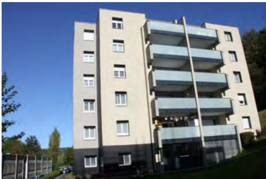
Les bâtiments A, B, E et F ont déjà bénéficié des travaux de rénovation énergétique
