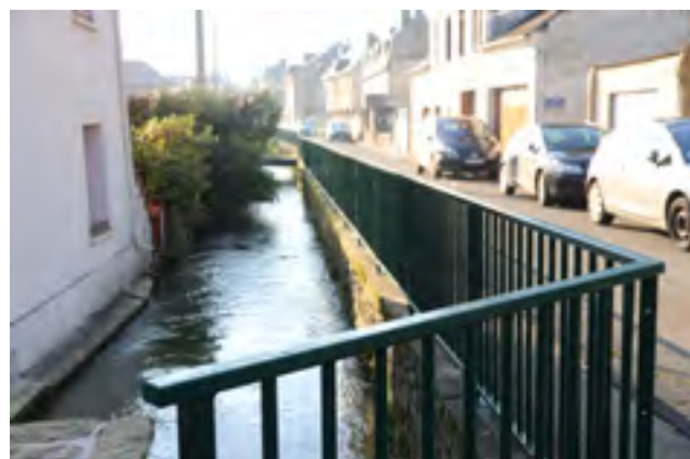
Remise aux normes de la barrière main-courante rue Gouvermoulins
