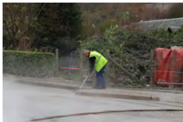
Afin de sécuriser la rue Gouvermoulins, le stationnement est modifié, des bordures installées et les trottoirs élargis.
